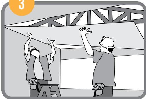
Colocación de las placas de cielo raso CIEL fijadas a perfiles omega y colocación de placas de yeso en derrames de puertas y ventanas según detalle.
